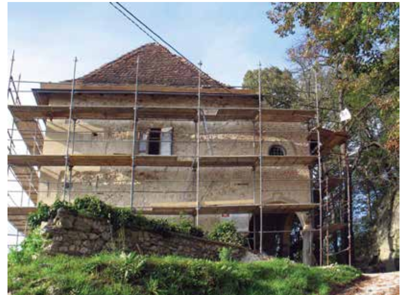
Stari grad - Palas za vrijeme radova sanacije
